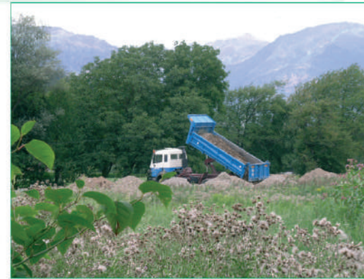
Un cas de figure très fréquent : cette plateforme de stockage de matériaux est devenue une plaque tournante de dispersion pour les Renouées.
